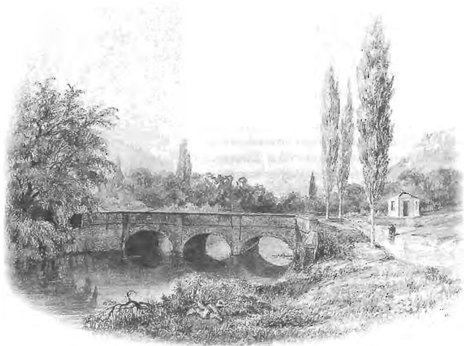
Чоргунский мост-акведук. Построен в 40-е гг. XIX в. по инициативе адмирала М.П. Лазарева. Являлся частью самотечного водопровода длиной 18 км, подававшего воду в сухие доки Лазаревского Адмиралтейства в Севастополе. Рисунок Л.Ф. Лагорио.
