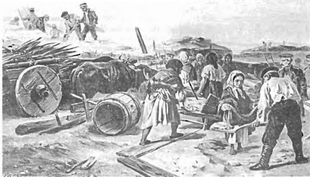
Строительство укреплений в Севастополе. Масло. 1871–1872 г. Альбом «Эпизоды Севастопольской жизни 1854–1855 годов». Худ. И. М. Прянишников.
