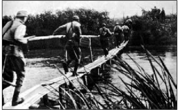
Штурмовые мостики через реку
