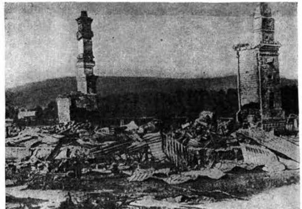
Разрушенные японцами здания в Николаевске-на-Амуре. Март 1920.
