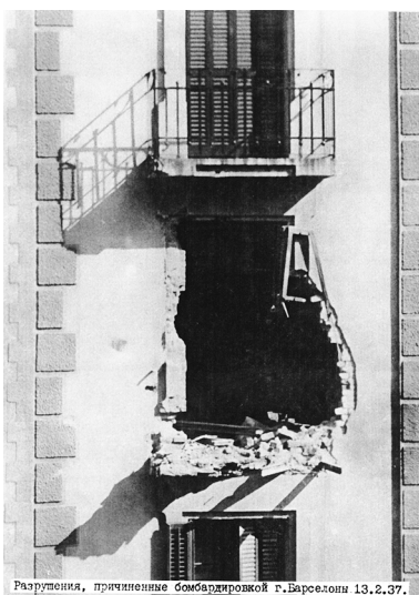
Разрушения, причиненные бомбардировкой г. Барселоны 13.2.37.
