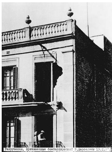
Разрушения, причиненные бомбардировкой г. Барселоны 13.2.37.
