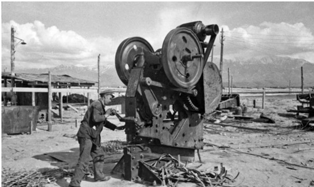
Монтаж эвакуированного оборудования. 1941 г.
