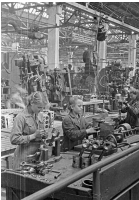
Сборка поршней двигателей в цехе Уральского автомобильного завода имени И. В. Сталина. Миасс, 1944 г.
