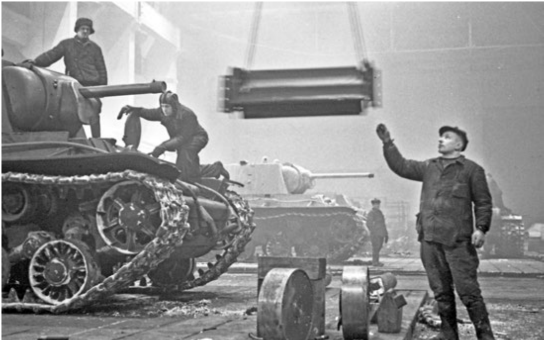
Сборка самоходных артиллерийских установок на Кировском заводе. Челябинск, 1944 г.
