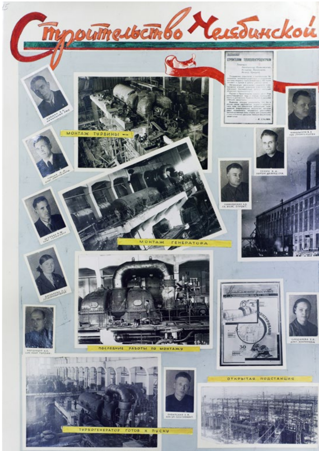
Строительство Челябинской ТЭЦ-1. 1944 г.
