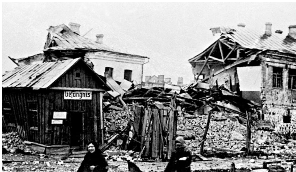
Здание тюрьмы, взорванное оккупантами при отступлении в 1943 г. БГАКФФД.
