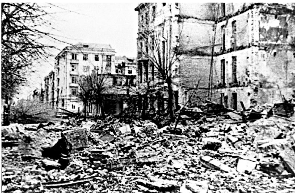
Разрушенные здания на одной из улиц г. Гомеля после освобождения от оккупантов. Ноябрь 1943 г. БГАКФФД.
