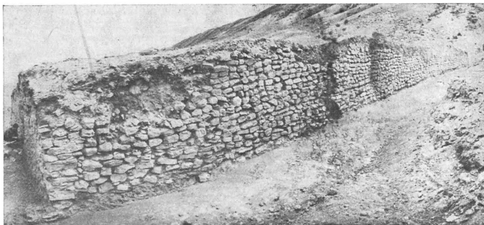
Рис. 35. Антисейсмические швы на внутреннем фасаде Верхнечирютовской оборонительной стены
