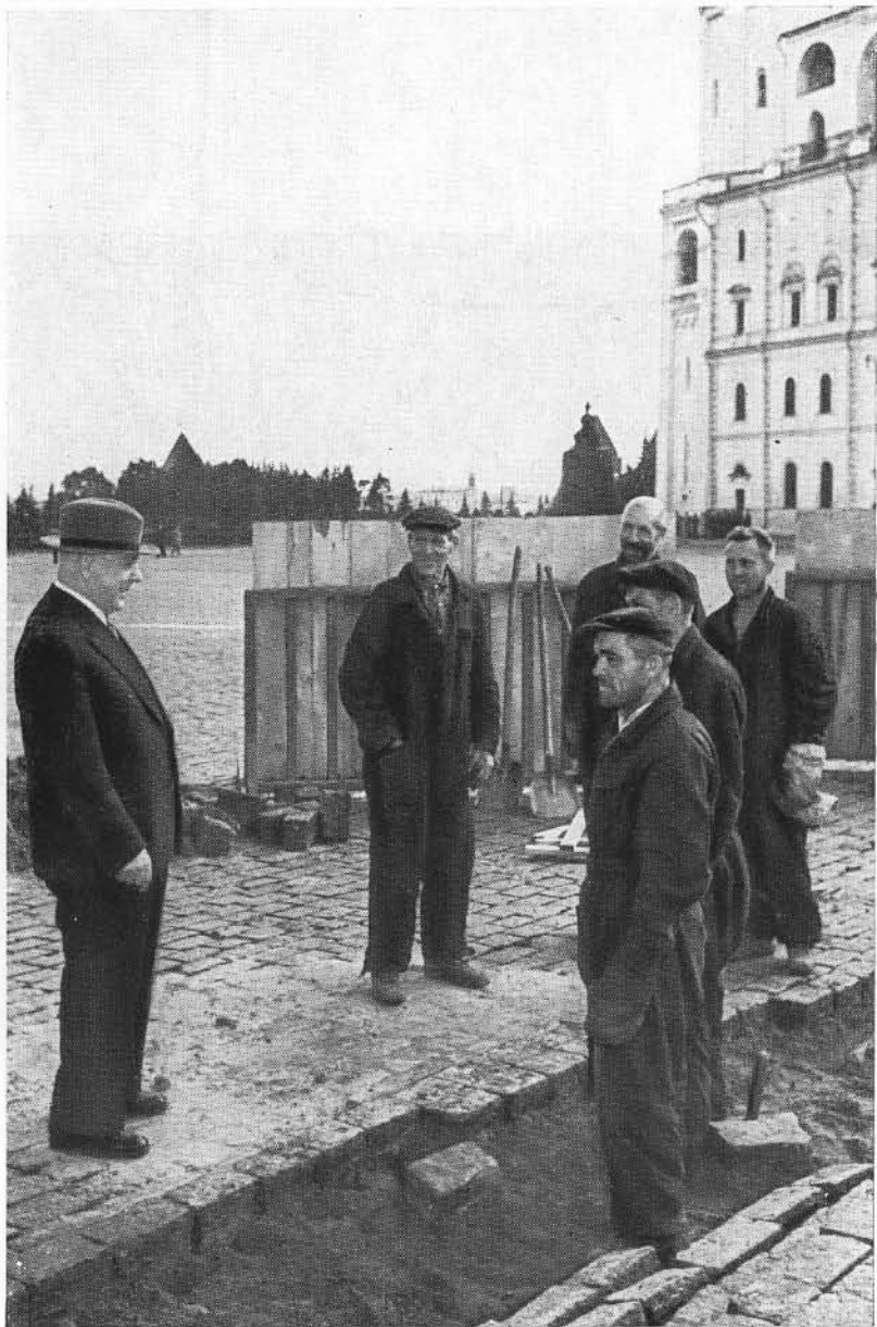
К. Е. Ворошилов беседует с рабочими, ремонтирующими мостовую в Кремле, 4 сентября 1956 г.
