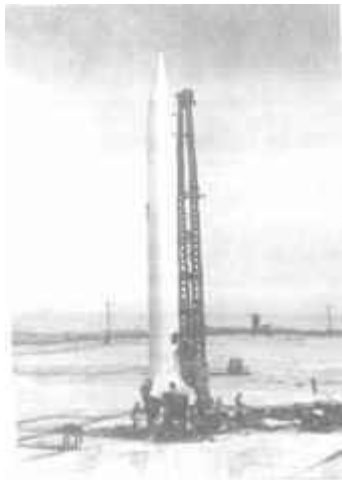
Установка ракеты Р-5М на пусковой стол
